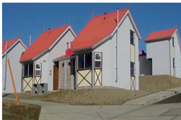
4. Reconstrucció d'edificis danyats a Xile, gener 2011
